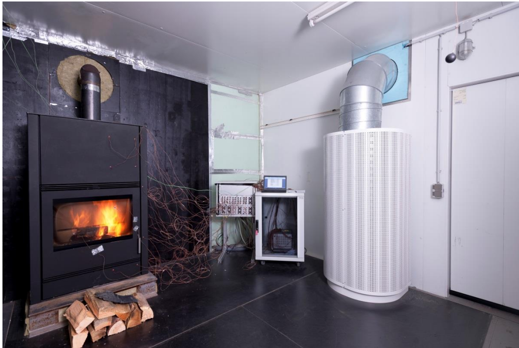
Abbildung 3: Kalorimeterraum des Fraunhofer-Instituts für Bauphysik IBP.
